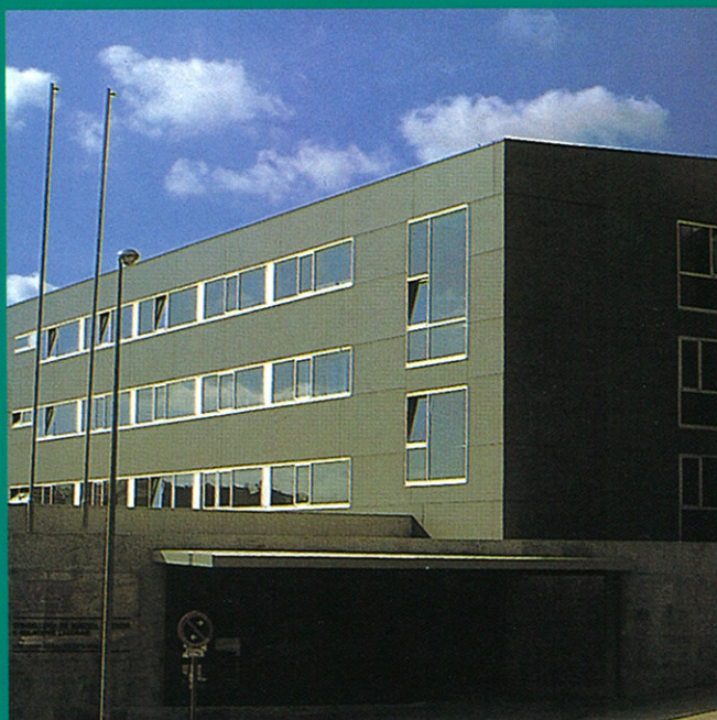
Instalaciones edificio de la Policía Autonómica
