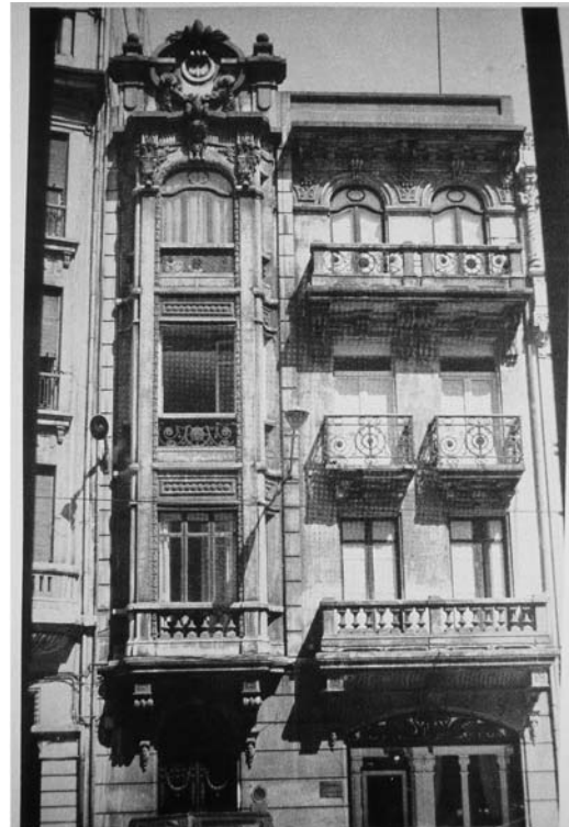
Calle Ferrol (A Coruña) nº 12 (1913). Arq: Eduardo Rodríguez-Losada Trulock. Edificio con muros de carga y forjados de madera con fachada de gran carga ornamental.
