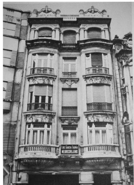
Calle Ferrol (A Coruña) nº 14 (1926). Arq: A. Tenreiro y P. Estellés. Edificio ecléctico. No tiene galería, ya que los grandes ventanales no tienen un muro detrás. Su aspecto es similar a los anteriores, pero su estructura está realizada en hormigón armado.
