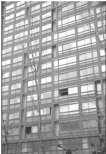
LA GALERÍA REINTERPRETADA, EL HUECO SOPORTA EL MURO
